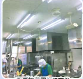
厨房抗菌電灯に交換
